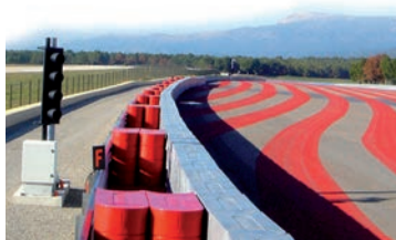
| Barreras Tecpro permiten mantener la hilera firme ante un impacto.
