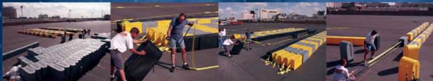
Installation d'une piste à Las Vegas, USA
